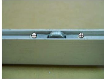
شكل رقم ٧١: عملية تركيب العجلات
