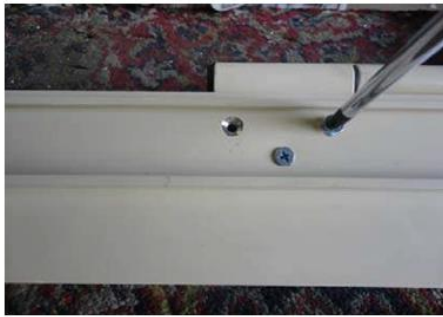
4. عملية الثقب والتركيب
