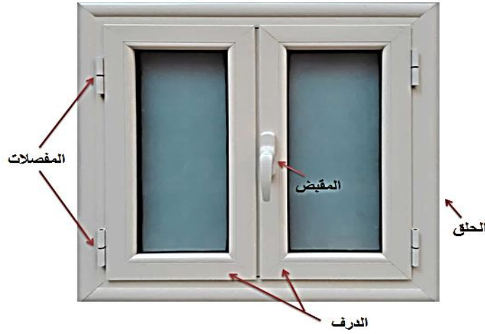
شكل رقم ٢: نافذة مفصلية بدرفتين، إتجاه فتحهما إلى الخارج
