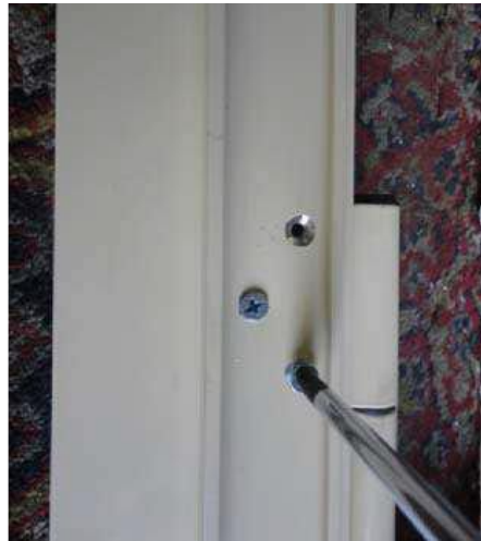
شكل رقم ٣٦: عملية تركيب المفصلة
