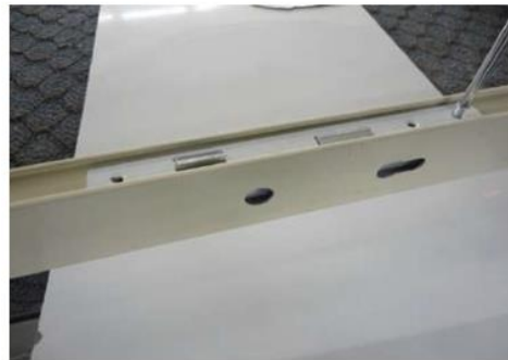
شكل رقم ٦٢: عملية تركيب الكالون بالدرفة
