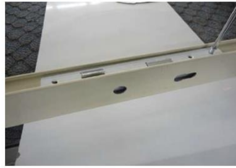
شكل رقم ٤٢: عملية تركيب الكالون بالدرفة
