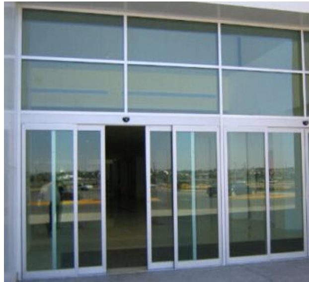
شكل رقم ٩: قاطوع ثابت مع باب سحاب أتوماتيكي
