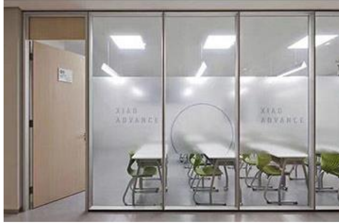
شكل رقم ٧: قاطوع ثابت مع باب مفصلي ذات إتجاه واحد للفتح
