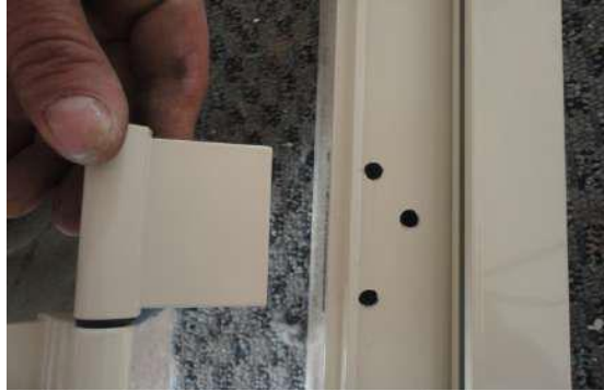
شكل رقم ٤٧: عملية نسخ الثقوب
