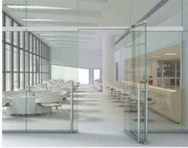
شكل رقم ٨: قاطوع ثابت مع باب مروحي
