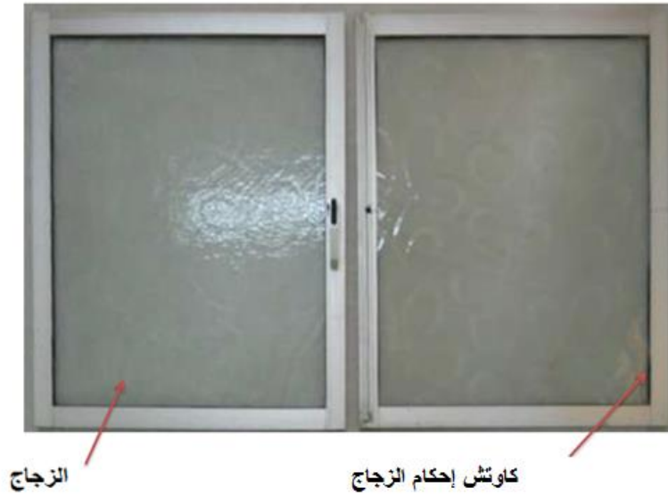
شكل رقم ٧٠: الشكل النهائي لدرفتي النافذة
