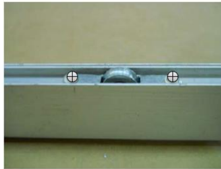
شكل رقم ٤٧: عملية تركيب العجلات
