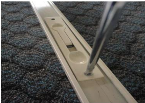
4. عملية الثقب والتركيب
