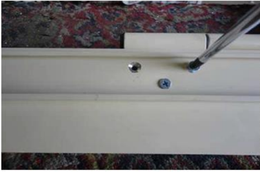
4. عملية الثقب والتركيب
