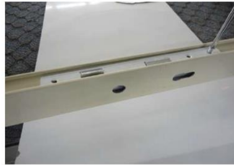
شكل رقم ٦٤: عملية تركيب الكالون بالدرفة
