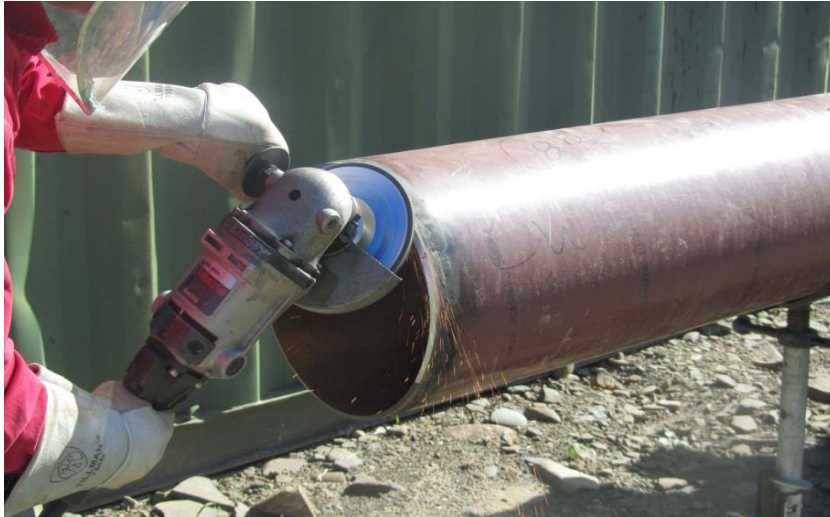
شكل رقم ١٢٠: تجليخ نهاية خط القطع
