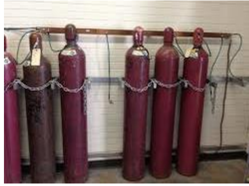
شكل رقم ٢١: تخزين أسطوانات الاستيلين
