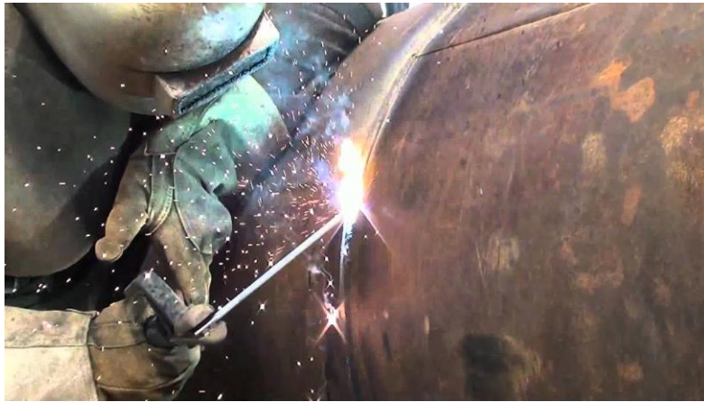
شكل رقم ٦٣: لحام خطوط اللحام بالقوس الكهربائي بشكل منتظم
