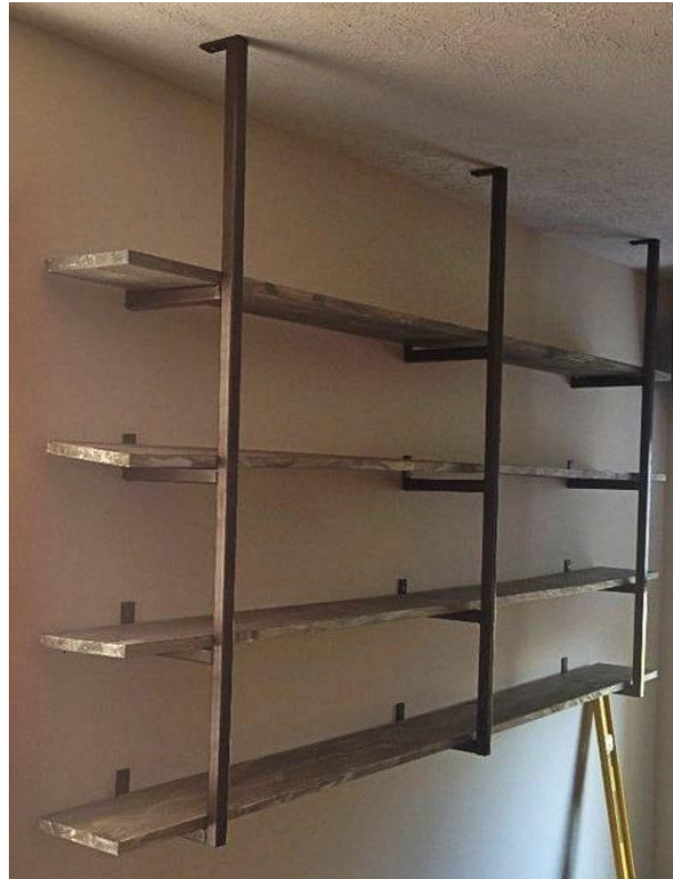
شكل رقم ٩٦: تعليق الارفف الصناعية
