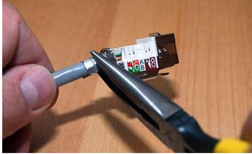
شكل رقم ١٢٥: عملية تثبيت وصلة التأريض (Shielding)
