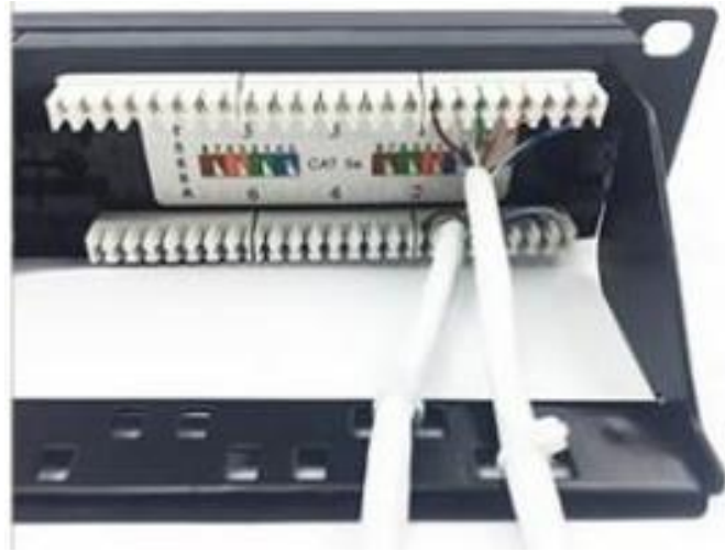
شكل رقم ١٣٦: تثبيت الكابلات باستخدام أحزمة الربط البلاستيكية (Tie Strap)
