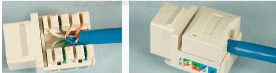
شكل رقم ١١٤: تركيب الغطاء الخارجي لمقبس RJ45
